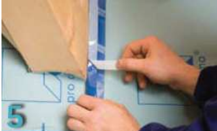
Detail: nurkade liimimine
